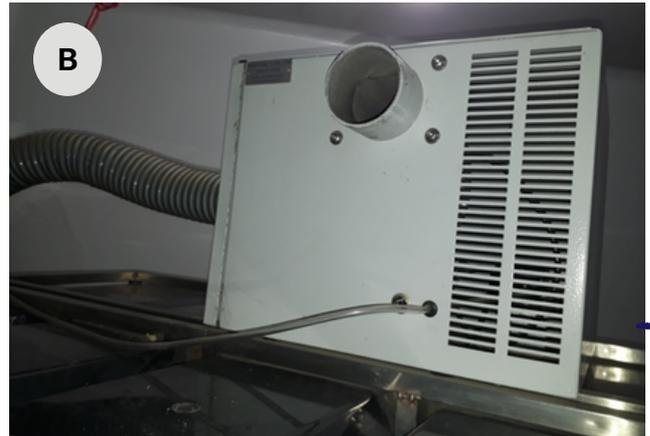
Motor de saída de ar e conexões. À esquerda, está localizada a mangueira de saída de ar que é conectada ao encanamento.
