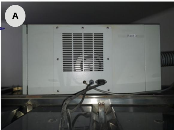
Motor de entrada de ar e conexões. À direita, está localizada a mangueira de entrada de ar que é conectada ao encanamento.
